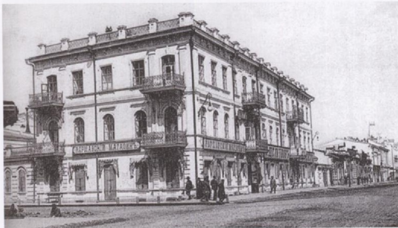
Гостиница «Деко» в Иркутске (здание на углу улиц в центре снимка), где в 1919—1920 гг. жил А.И. Погребецкий. Фото первой четверти XX в.
